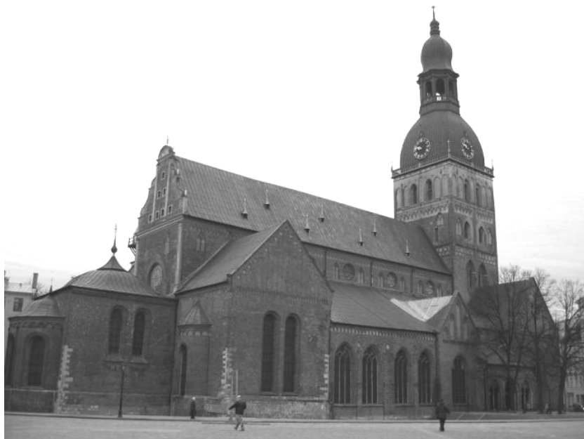
2.12. att. Doma baznīcas ziemeļu un austrumu fasādes [autora foto]
