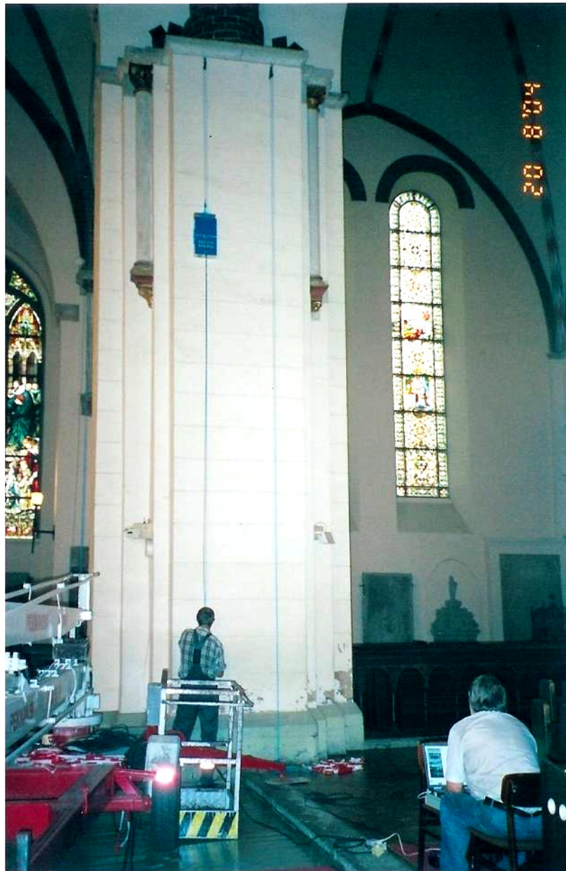
Att. 2.22. Kolonas (zona „L”) skanēšana ar ģeoradaru [81].
