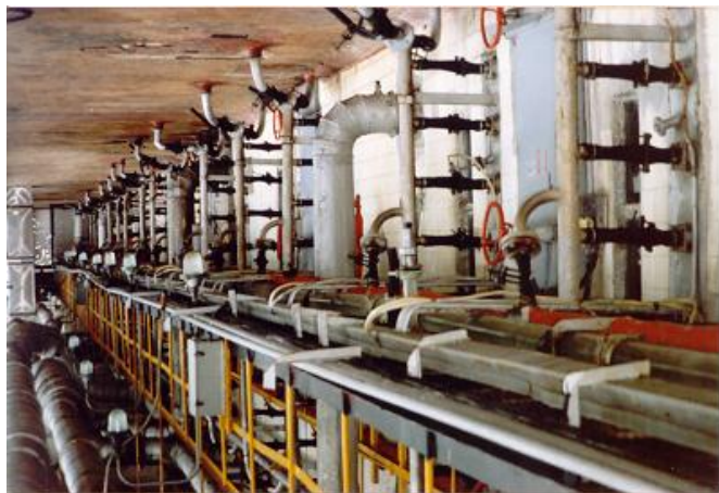
3.zīm. „Biolar” itakonskābes ceha raudzēšanas iekārta.
