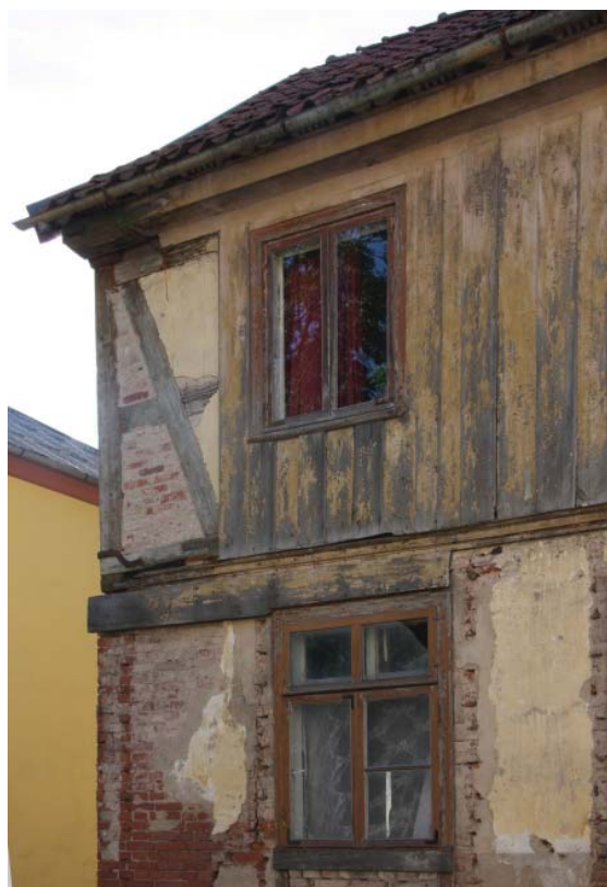
13. att. Dzīvojamā ēka Lielajā ielā 9. Pildrežģa fragments [11] Fig. 13. Dwelling house at Lielā iela 5a. Fragment in half-timber [11]
