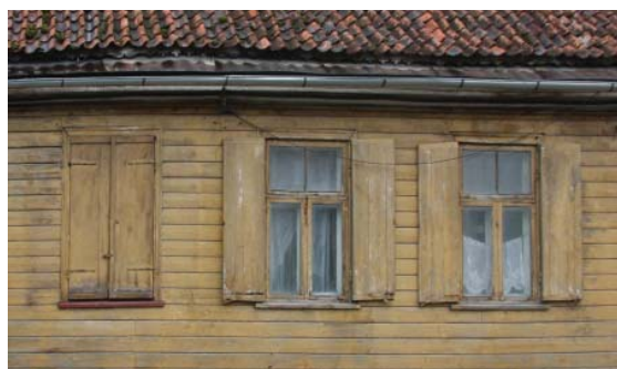
11. att. Logi ar slēģiem Kuldīgas ielā 5 [11] Fig. 11. Windows with shutters at Kuldīgas iela 5 [11]
