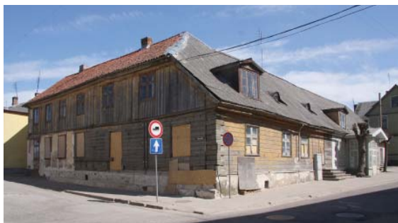
8. att. Dzīvojamā ēka Lielajā ielā 9 [11] Fig. 8. Dwelling house at Lielā iela 9 [11]
