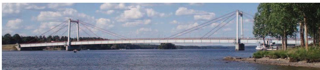
1.2. att. Stromsunda tilts Zviedrijā
