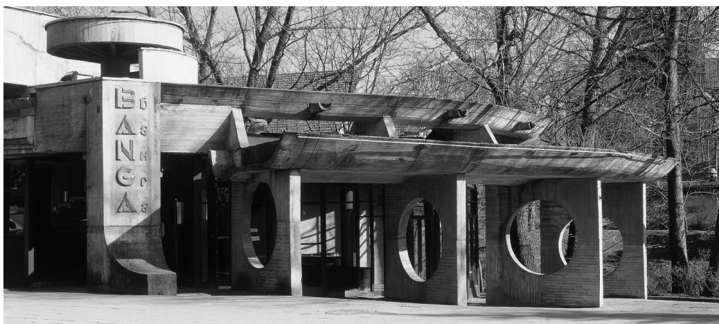
Fig. 8. Coffee shop pavilion "Banga", J. Basanavičiaus g. 2, 1976–1979, demolished in 2015, architect Gintautas J. Telksnys [Photo: Arūnas Baltėnas, 2005, source: Navickienė E., Vaitys L., Karpavičius E. Architektas Gintautas Telksnys . Vilnius: Artseria, 2005].
