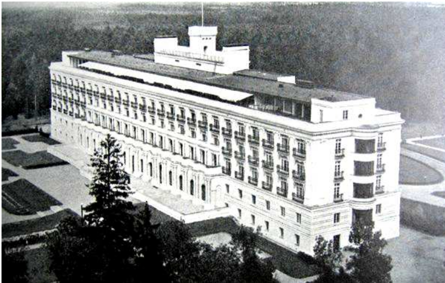
5. att. Viesnīcas dienvidrietumu fasāde ar galveno reprezentācijas telpu anfilādi 1. stāvā un luksusa apartamentiem 2. stāvā. 30. gadu foto.
