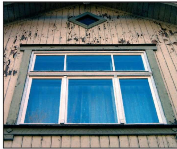
23. attēls. Lielā iela 29.
