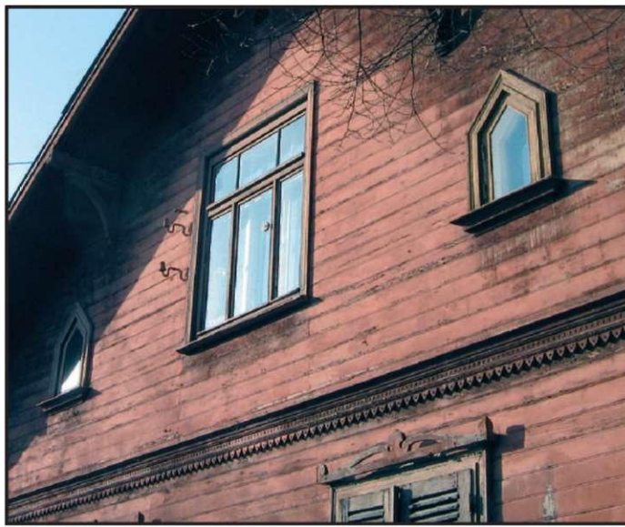
21. attēls. Āgenskalna iela 8.
