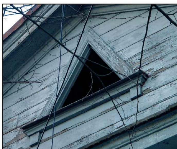
40. attēls. Lielā iela 9.
