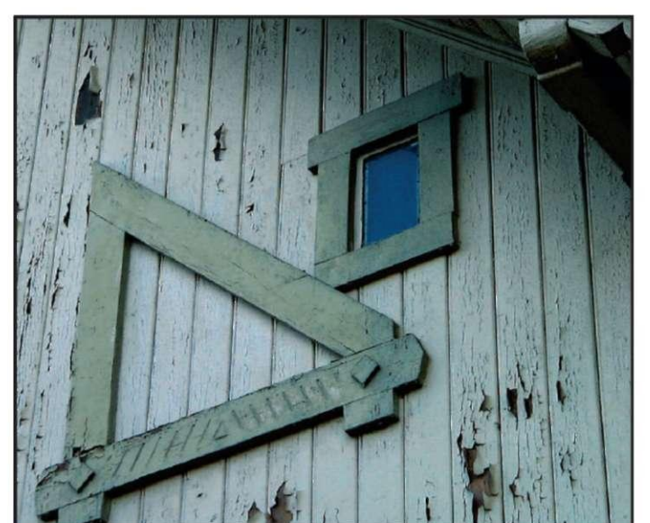
37. attēls. Lielā iela 29.
