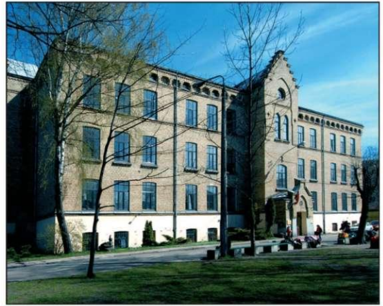
4. attēls. Pilsētas pamatskola Skrindu ielā 1. 1902–1903. R. Šmēlings.
