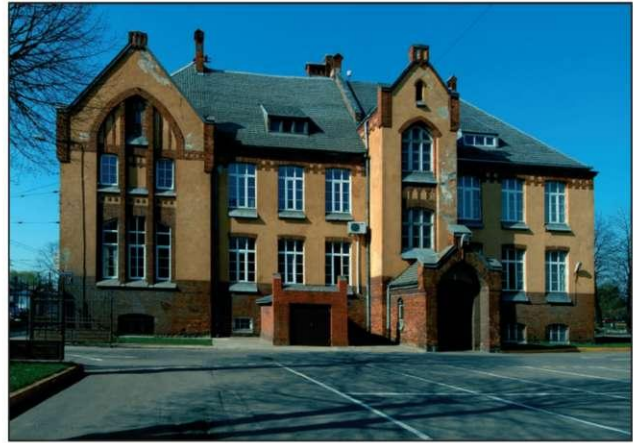
12. attēls. Pilsētas pamatskola Raņķa dambī 1. 1910–1911. R. Šmēlings.
