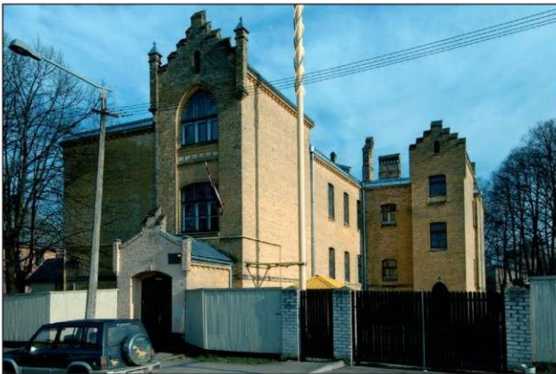
7. attēls. Pilsētas pamatskola Slokas ielā 65. 1908–1909. R. Šmēlings.
