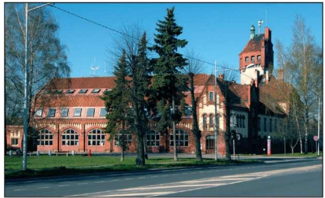
55. attēls. Ugunsdzēsēju depo Hanzas ielā 5. 1909–1910. R. Šmēlings.
