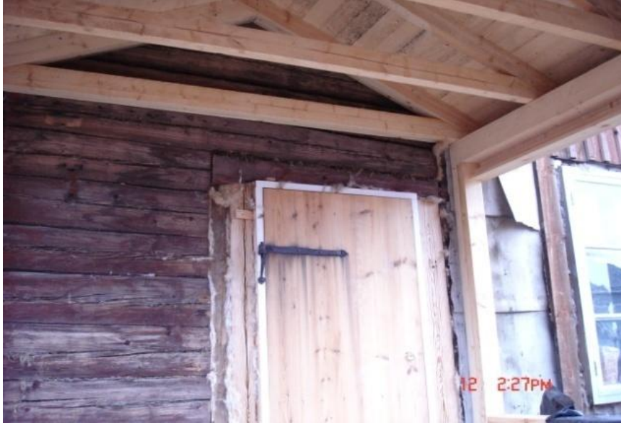
4. att. Ēkas piebūves būvniecība, kurā tiek iebūvētas jaunas durvis, bet pielietoti vēsturiskie metāla kalumi
