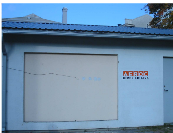
1. attēls. Jaunās paaudzes gāzbetona bloku sienas fragments
