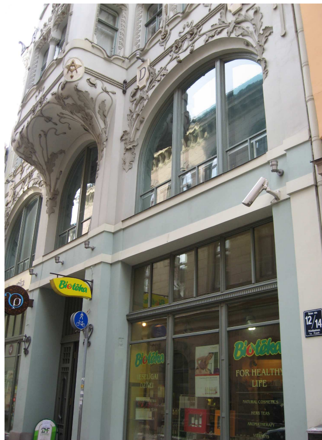
5.att. Nams Šķūņu ielā 12/14 (I. Griņeviča foto)
