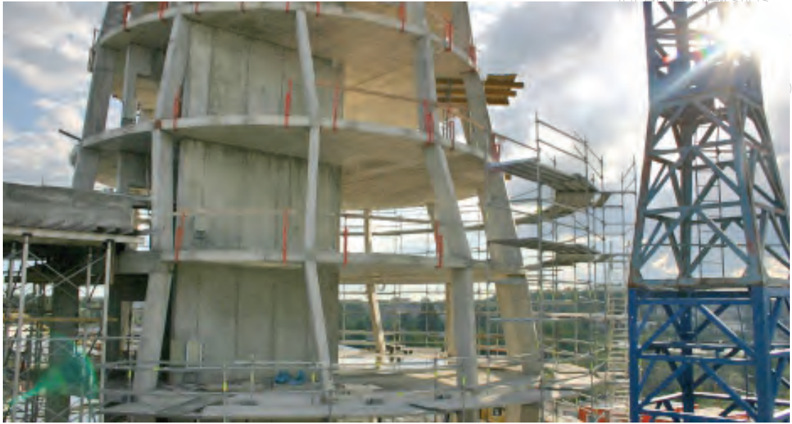
2.58. att. „RBS Skals“ biroju ēkas Ķīpsalā centrālā apjoma būvniecības stadija.
