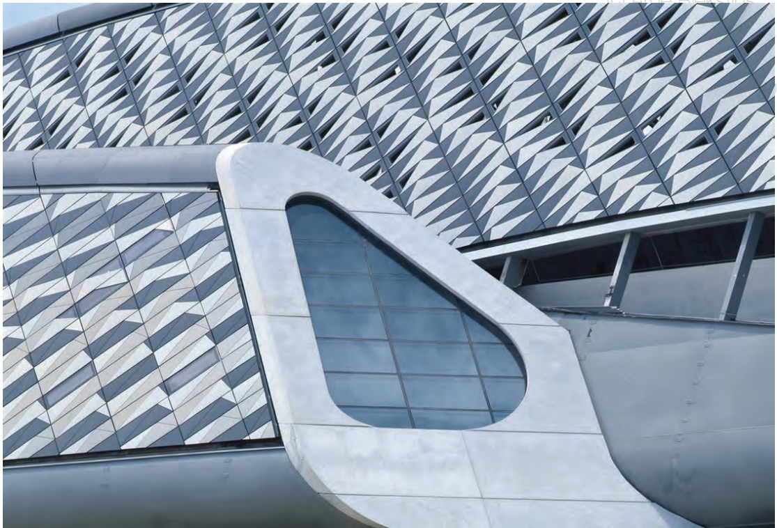
2.32. att. Tilta fasādi veido unikāli rotētas un grieztas dažādu krāsu betona plāksnītes, kas optimizētas regulāros četrstūru laukumos un maksimāli 10 griezuma variācijās. Vizuālu atšķirību piešķir izvēlētais plāksnišu materiāla tonis.
