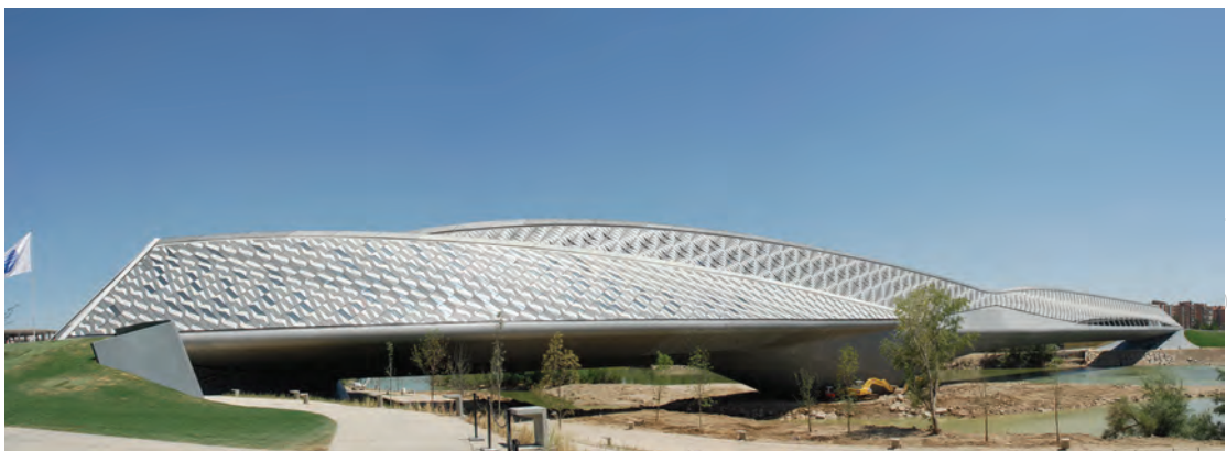
2.29. att. Pasaules izstādes Expo 2008 tilts Saragosā. [A.R.]
