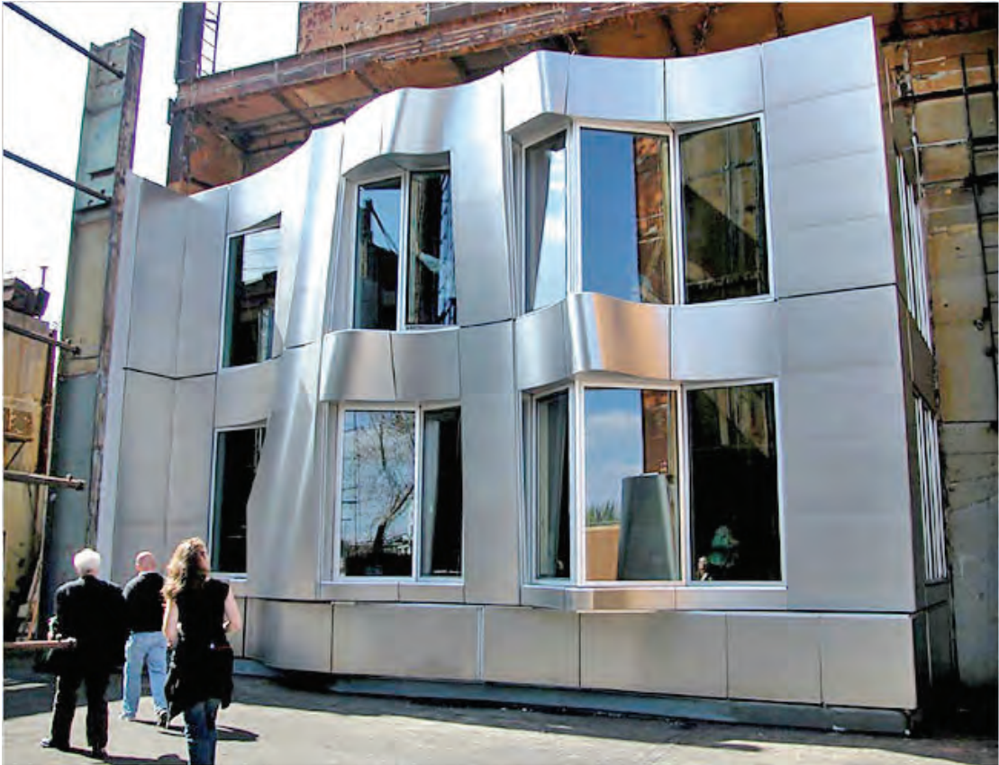
2.9. att. Ēkas fasādes fragmenta makets mērogā 1:1, lai pārliecinātu klientus par viļņojuma vizuāli estētisko efektu un par to, ka šāda fasāde vispār realizējama.
