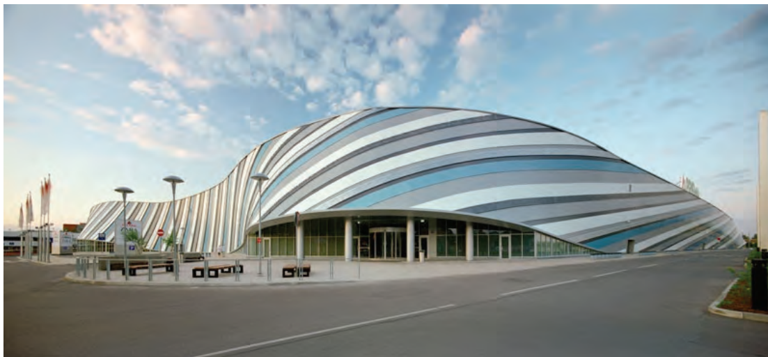
2.65. att. Rīga Plaza fasāde „apvij“ visu būvapjomu.
