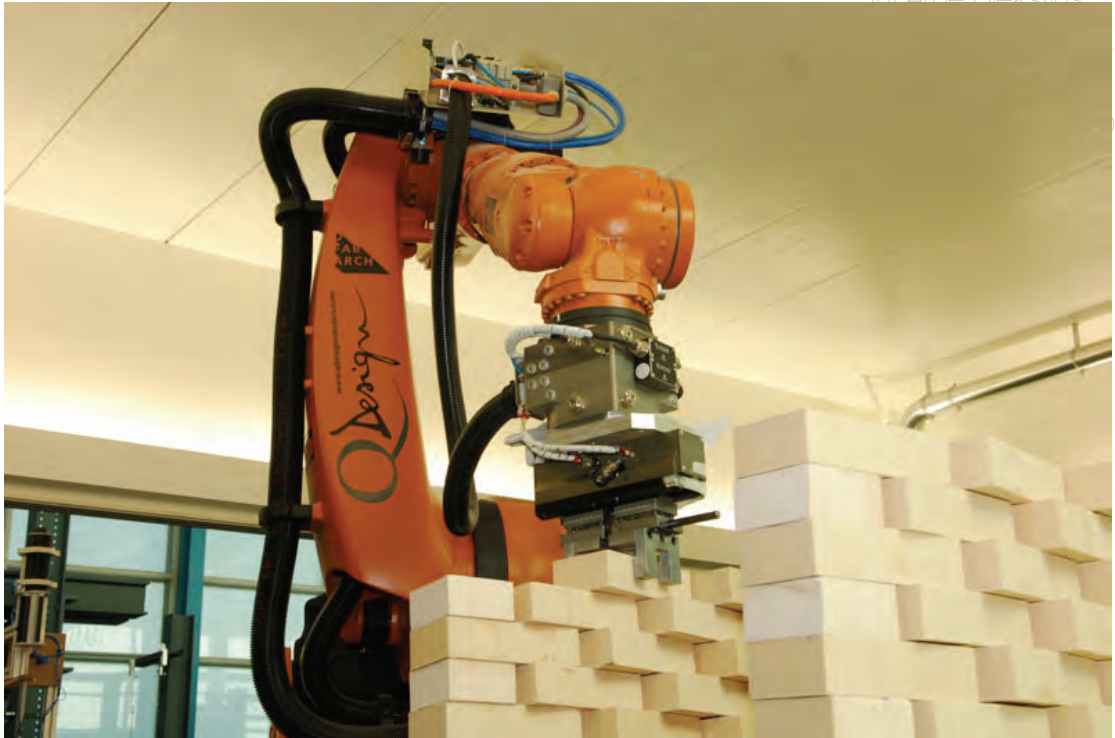
2.25. att. Vīna fermentācijas ēkas fasādes būvēšana ar robota palīdzību.
