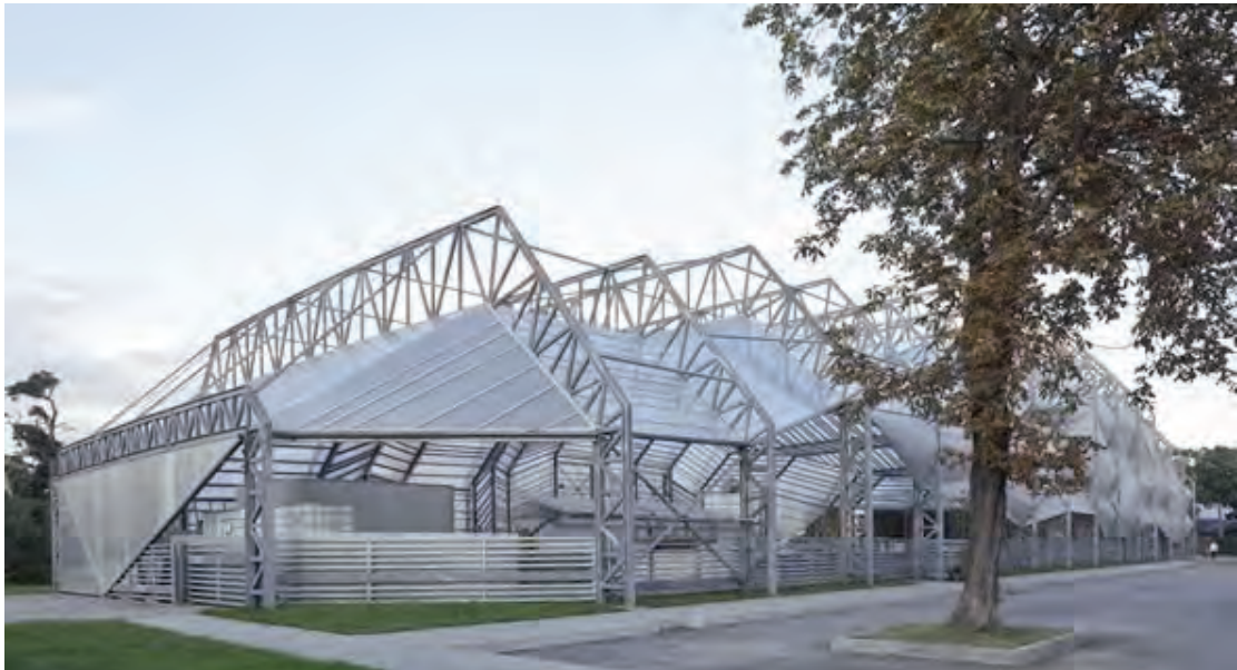
2.51. att. Majoru pamatskolas sporta laukuma konstrukciju kopnes izceļ tā biomorfiskās aprises.
