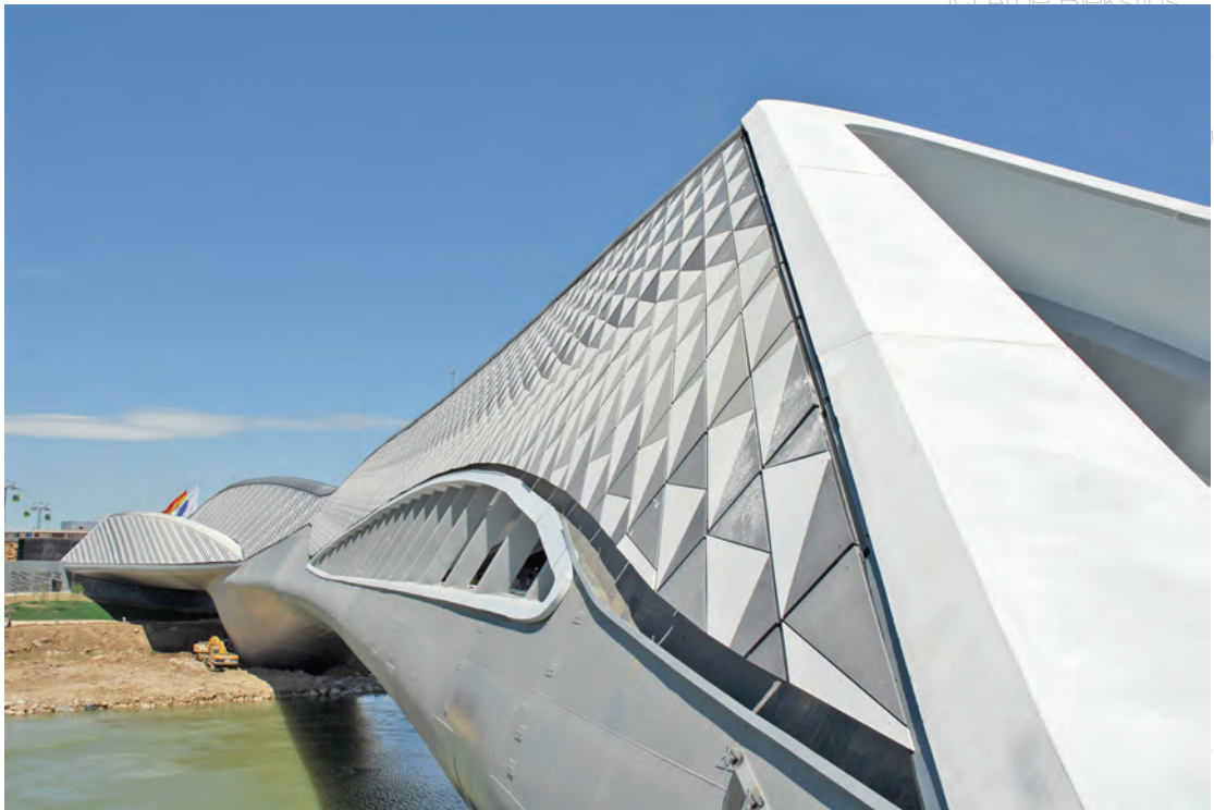
2.31. att. Expo 2008 tilta metāla konstrukcijas paslēptas zem plūdenas biezas metāla virsmas, līdzīgi kā kuģu korpusu konstrukcijās. [A.R.]
