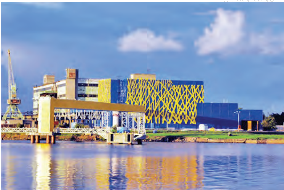
2.50. att. Skats uz sulu termināli no Ventas upes, ar līnijām dekorēta rezervuāru parka ēka.
