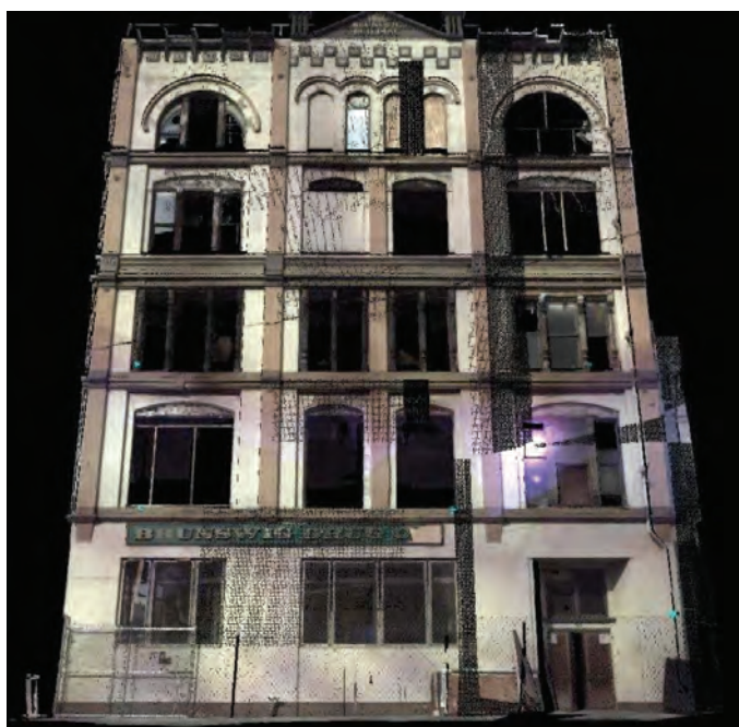
1.41. att. Ar trīsdimensiju lāzera skeneri uzmērīta ēkas fasāde Losandželosā.
