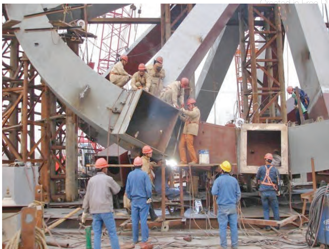
2.22. att. Stadiona nesošā karkasa montāža būvniecības procesā.
