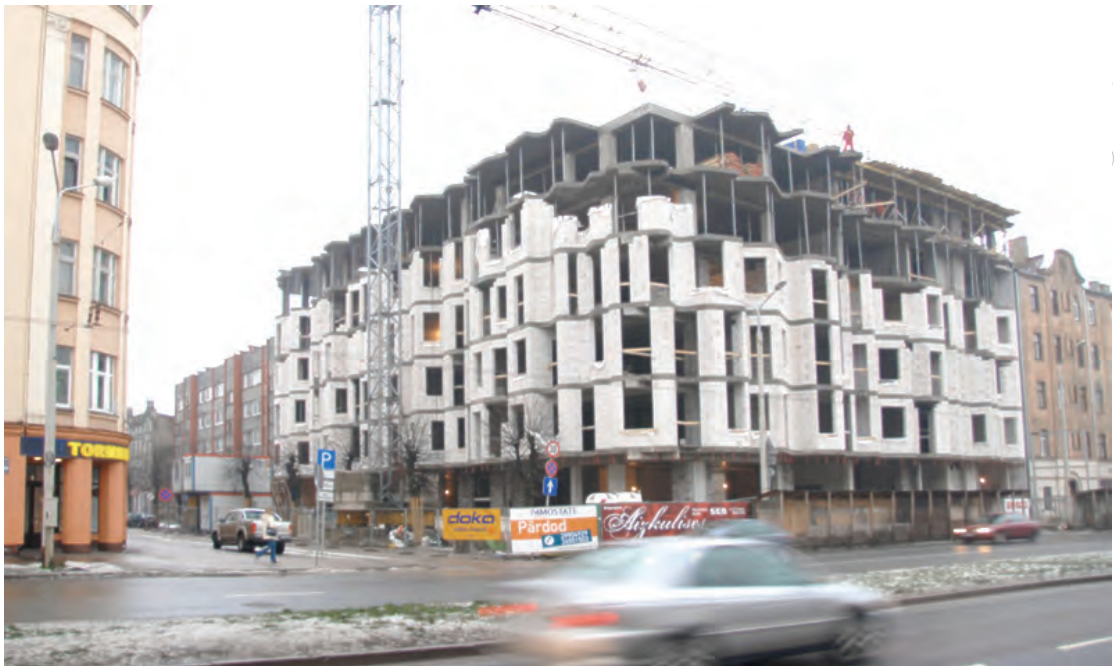
2.56. att. Projekta „Aizkulises“ nepabeigtais būvobjekts Čaka un Alauksta ielu stūrī, Rīgā.
