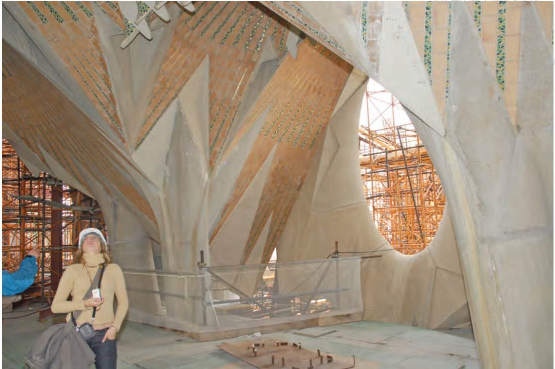
2.7. att. Griestu detaļa nepilnus piecdesmit metrus virs grīdas līmeņa. Katrs elements nostrādāts ar visaugstāko precizitāti, kas bijis iespējams, pateicoties datorizētajiem ražošanas procesiem. [A.R.]
