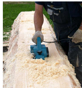
10.att. Virsmas nolīdzināšana ar elektrisko ēveli
