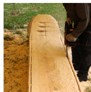
15.att. Malu atzāģēšana laivas iekšpusē
