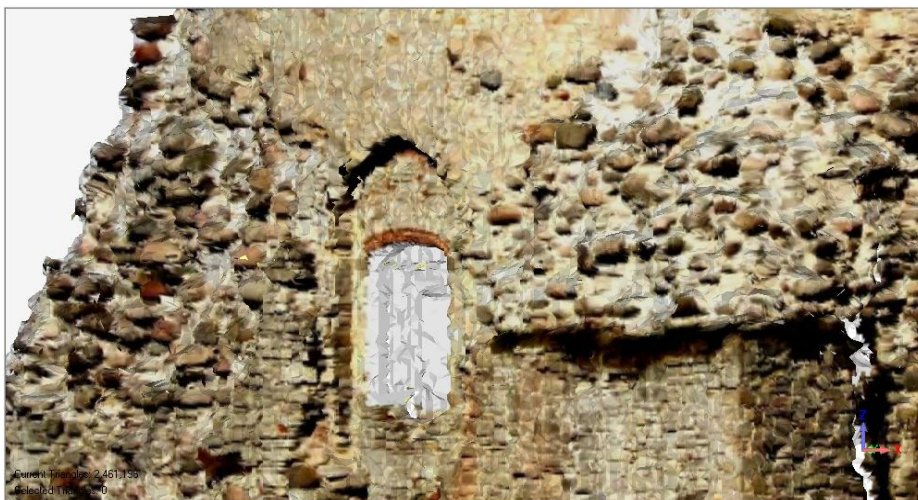
6. att. Cēsu pilsdrupu daļas - Ziemeļu korpasa sienas modeļa faktūrkartēšanas piemērs Geomagic Studio 12 vidē (autore veidots, izmantojot [1] datus).
