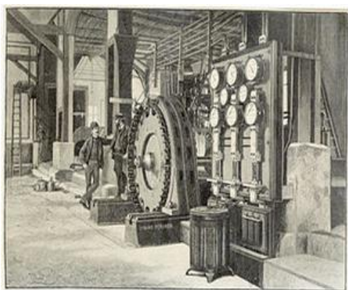
5. att. Laufenē uzstādītā trīsfāžu dinamomašīna.
