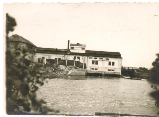
5. att. Aiviekstes komplekss, ap 1940. gadu; centrā spēkstacijas ēkas daļa 2 turbīnām, pa labi – brīvslūžas, pa kreisi – ēkas daļa ģeneratoriem, lokomobiles novietne ar kūdras krātuvi.
