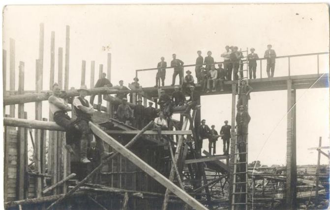
2. att. Jaunās spēkstacijas ēkas būvbedre, 1931. gads.
