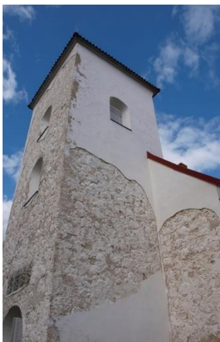
1.3. attēls. Hidraulisku īpašību trūkuma izraisītas sekas Puzes baznīcas restaurācijā (2011. g.).
