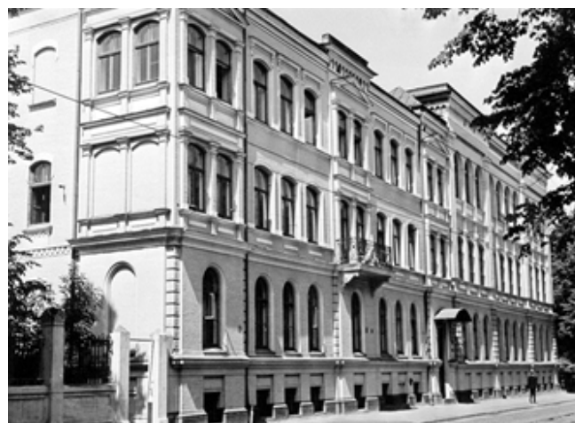
2. att. Ēka Kronvalda bulvārī 1 pēc 1968. gadā veiktā remonta. Foto no RTU Vēstures muzeja fondiem.
