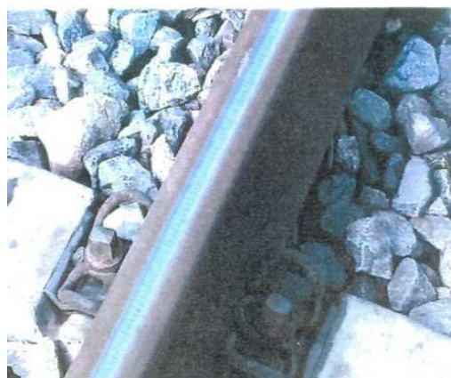
Рис.3. Рабочая поверхность отшлифованного рельса с помощью "SPENO RR40 MF2"
