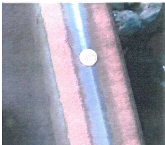
Рис.3. Рабочая поверхность отшлифованного рельса с помощью "SPENO RR40 MF2"
