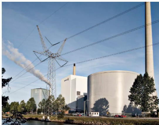
2.10. att. Bezspiediena tvertne pie Fynsværket koģenerācijas stacijas Odensē, Dānijā
