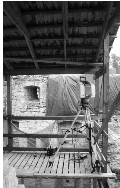
2.att. Leica HDS 3000 lāzerskeneris darba procesā pils pagalmā
