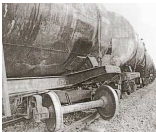
1.5. att. Vagona nobraukšana no sliedēm ratiņu iekļīšanās dēļ
