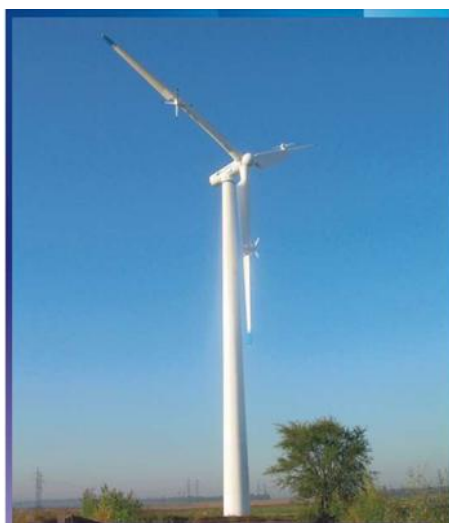
1.3.att. Vēja elektriskā iekārta ТГ-750
